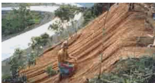
Układanie sieci Coconet. Źródło: Cocogreen 115
