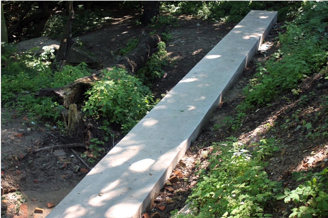
Betonowe wzmocnienie w górnym biegu potoku Babidolskiego, którego estetyka wymaga poprawy.
