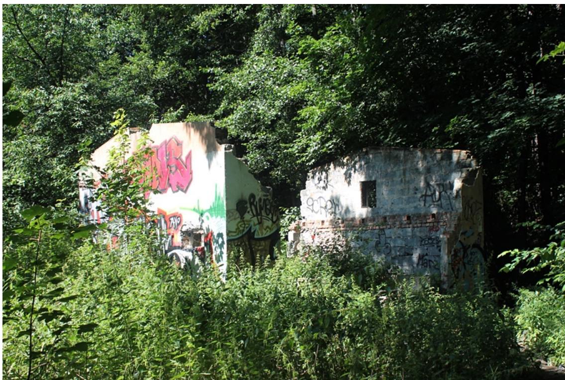
Ruiny nad potokiem Grodowym - do usunięcia.
