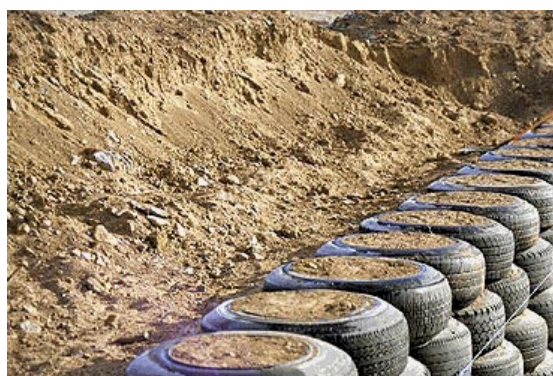
Ściana z opon w trakcie budowy.
