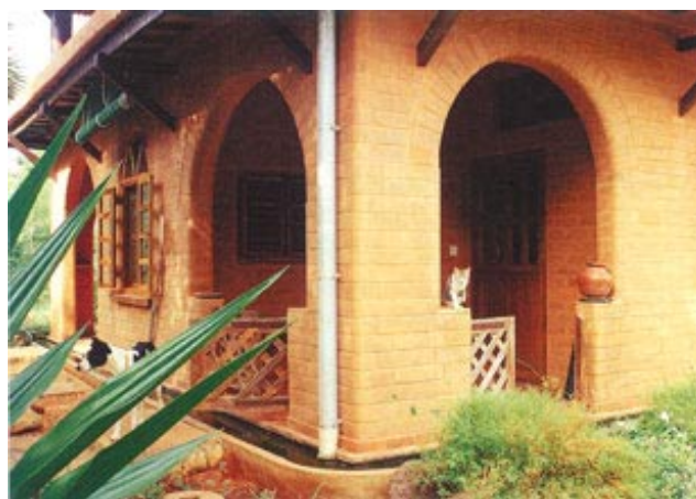
Dom wykonany w technologii CSEB. Źródło: Auroville Earth Institute 44 .
