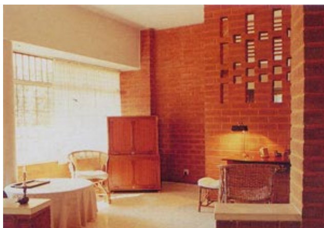
Wnętrze domu wykonanego w technologii CSEB. Źródło: Auroville Earth Institute 46 .
