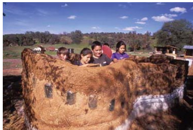
Budowa domku dla dzieci z cob w Meksyku. Źródło: Canelo project 32 .
