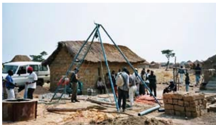
Budowa studni we wsi Kakalakassa w Angoli.
