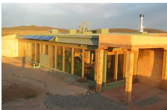
„Earthship” ogrzewany pasywnie, z modułami PV dostarczającymi energię elektryczną oraz systemem zbierania deszczówki.
